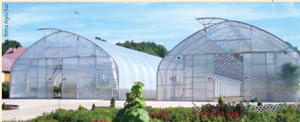
Fot. 1. Obecnie stawiane tunele umożliwiają intensywną wymianę powietrza
