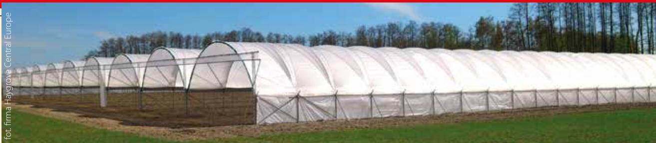
Fot. 5. Konstrukcja wieloprzędziałowa jest zaprojektowana tak, aby zapewnić swobodny dostęp ciągnika polowego do obiektu
