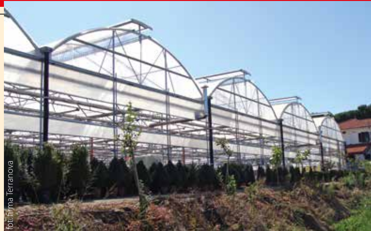
Fot. 7. Nowoczesne tunele pokryte poliwęglanem
